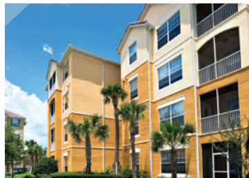
Pressurização de prédios residenciais (apartamentos, coberturas, áreas comuns)
