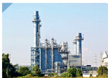
Pressurização de indústrias
