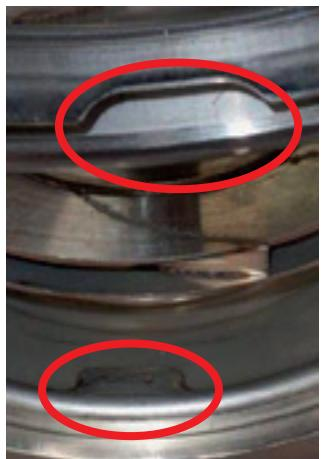
13. Detalhe da montagem correta do difusor, observando as partes com chanfro.
