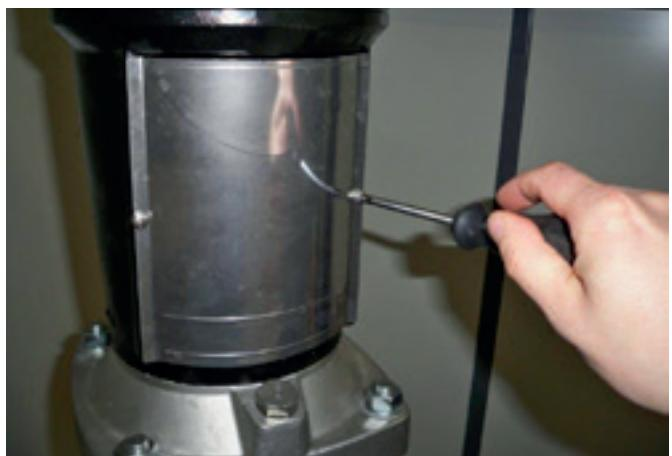
17. Com o auxílio de uma chave Philips, aperte os parafusos da tampa protetora. Repita a operação para a tampa localizada no lado oposto.
