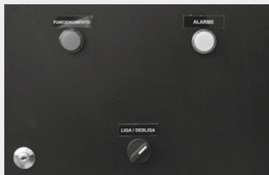
Figura 8 - Chave seletora na posição desliga
