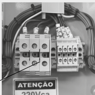
Figura 3 - Detalhe ampliado do conector de entrada de rede
