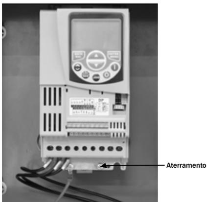
Figura 4 - Ponto de aterramento no inversor
